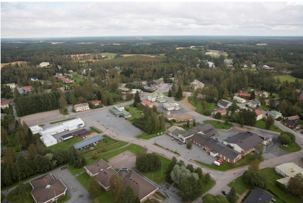
Ilmakuva Honkajoen taajamasta. Röni-Kuva Oy 2016.
