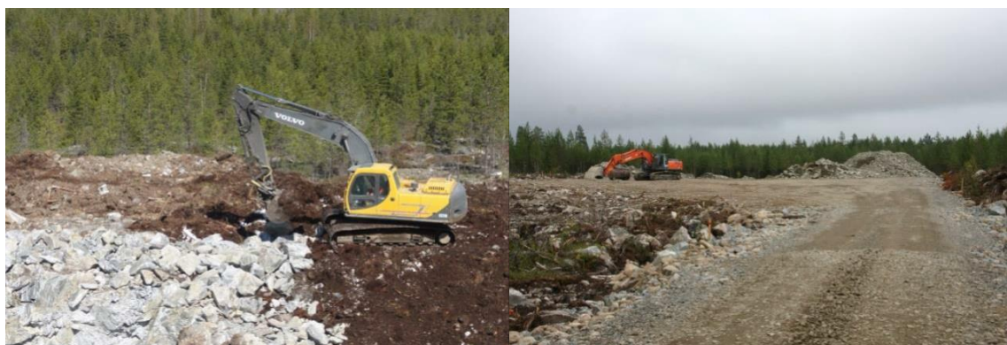
Kuva 46. Huoltoteiden ja pystytysalueiden rakentamista (Ville Suorsa, FCG)
