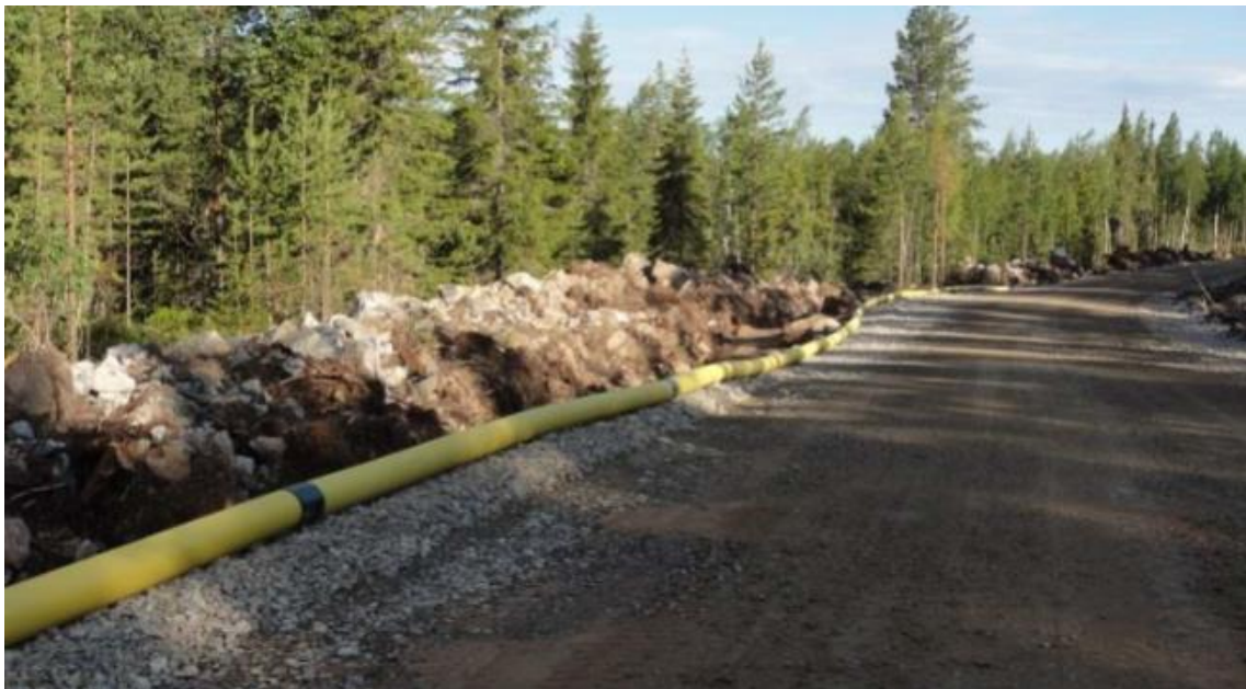
Kuva 45. Vasemmalla on esimerkki tuulivoimapuiston rakennus- ja huoltotiestä. Teitä käytetään muun muassa betonin, soran ja voimaloiden komponenttien kuljetuksiin sekä
