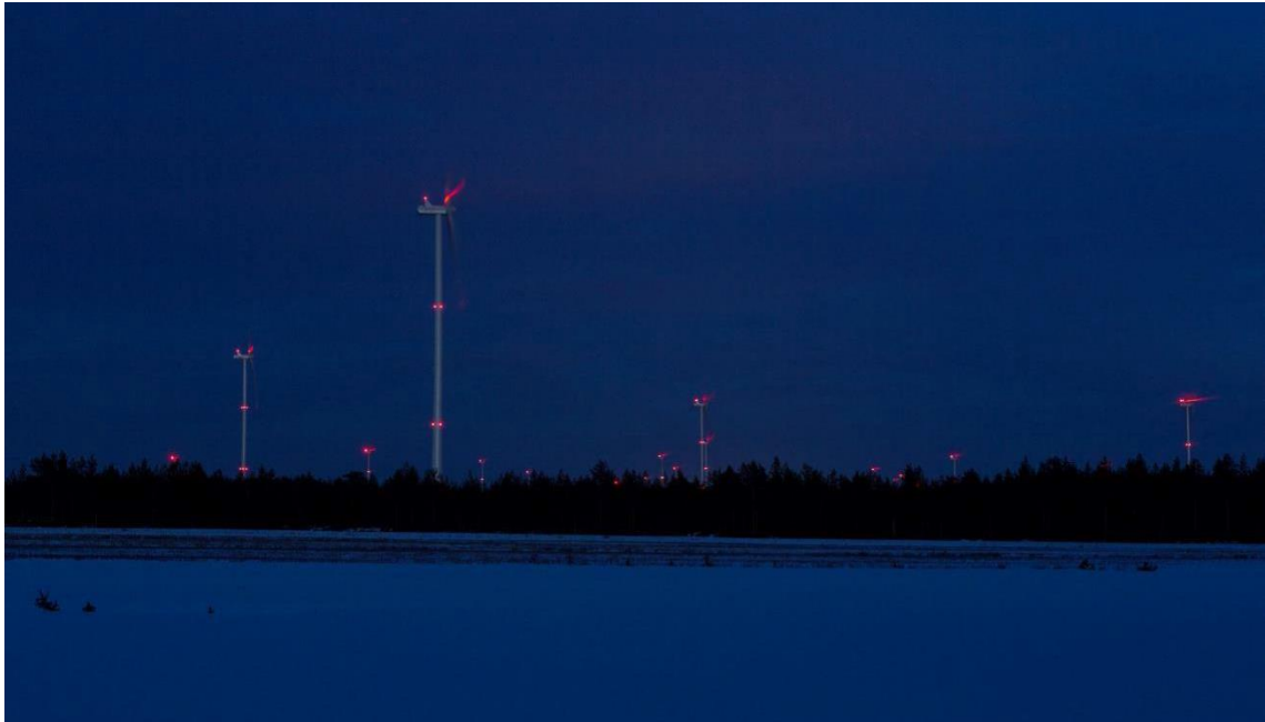
Kuva 42. Kiinteät punaiset lentoestevalot (Ville Suorsa, FCG)
