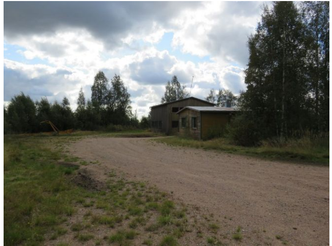
32. Rakennuksia Kurkikeitaan pohjoisreunalla.
