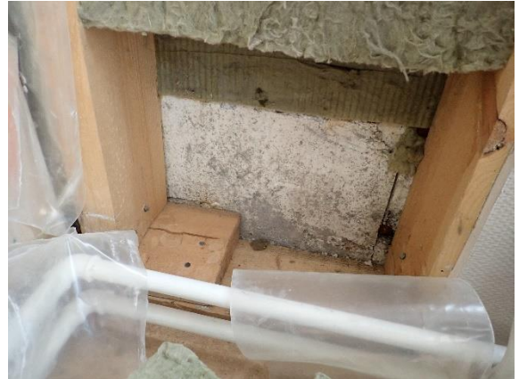
Kuva 21 Rakenneavauksessa ei silmämääräisesti havaittavissa viitteitä vaurioista (US3).
