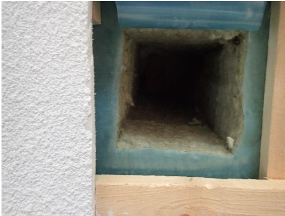
Kuva 183 YP8. Näkymä rakenneavukseen ylöspäin.
