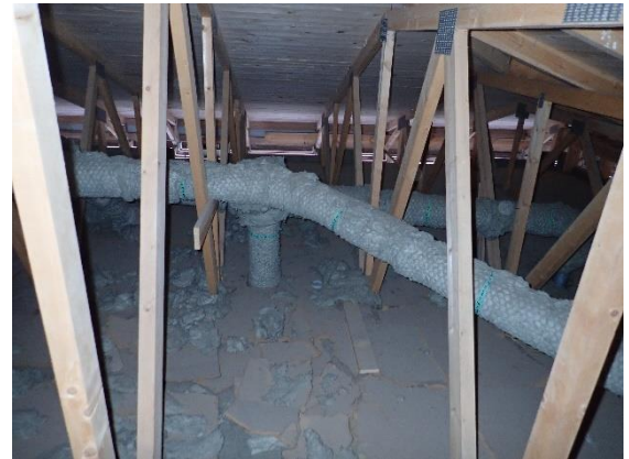
Kuva 58 Yleiskuva asunnon yläpuolisesta yläpohjatilasta. Yläpohjassa ei havaittu viitteitä vesikatevuodoista.
