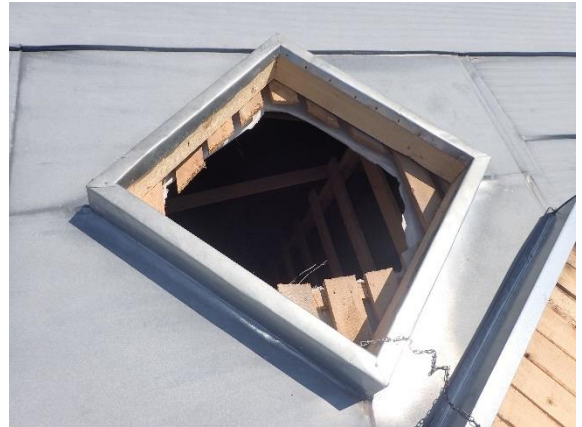
Kuva 192 Käyntiluukku 2002 rakennuksen kaakkoispäätyyn.
