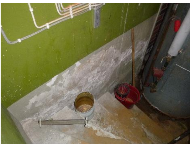
Kosteuden aiheuttamia vauriojälkiä maanvastaisissa seinärakenteissa.
