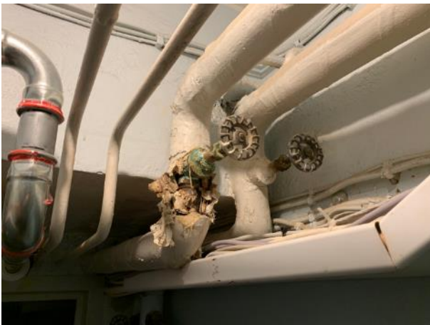
Asbestia sisältäviä putkieristeitä.
