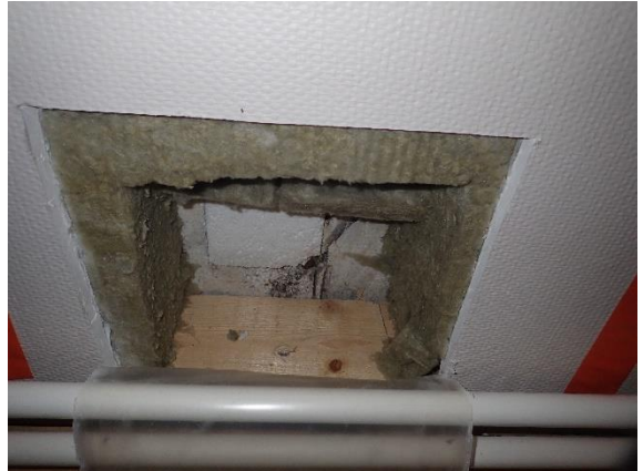
Kuva 25 Rakenneavauksessa ei silmämääräisesti havaittavissa viitteitä vaurioista (US4).
