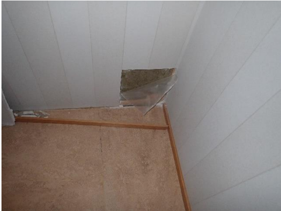
Kuva 16 Ulkoseinän rakenneavaus US1.
