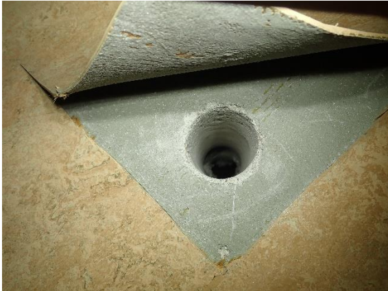
Kuva 46 Alapohjan rakennetarkastuspiste AP1.
