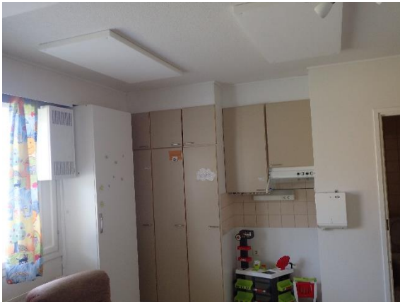
Kuva 207 1992 rakennuksen huonetilojen alakatot olivat kipsilevyä ja akustiikkaelementtinä oli akustovillalevyjä.
