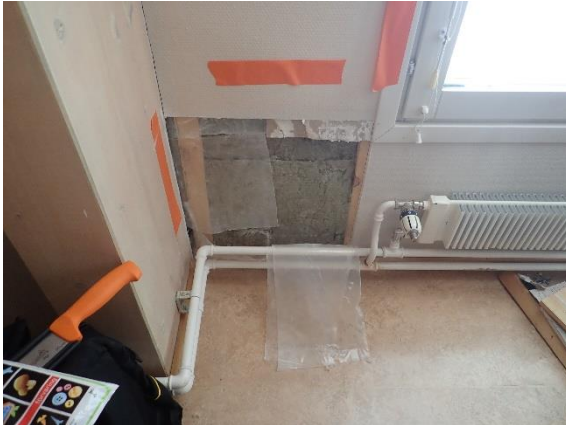
Kuva 20 Ulkoseinän rakenneavaus US3.
