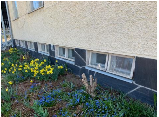
Seinustalle ulottuva kasvillisuus lisää lattia ja seinärakenteelle aiheutuvaa kosteusrasitusta.
