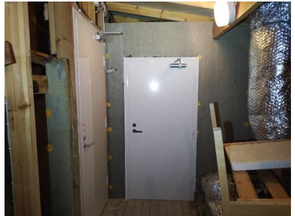
Kuva 202 Käytöstä poistetun rakennuksen toisesta kerroksesta, oli käynti ilmanvaihtokonehuoneisiin.
