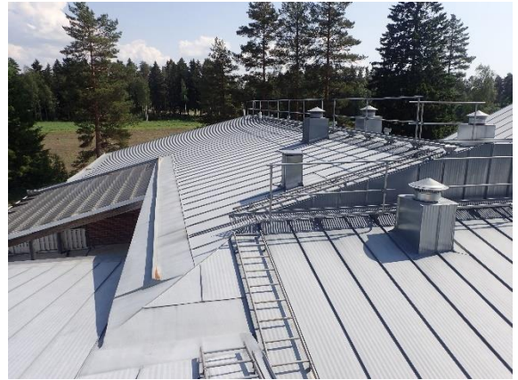
Kuva 190 Vesikatoilla oli asianmukaisen kulkutiet.
