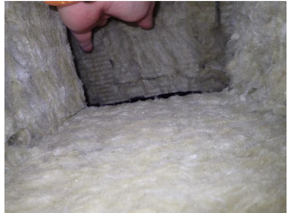
Kuva 158 YP3. Ylimmän levyn päällä oli puhallusvillaa.
