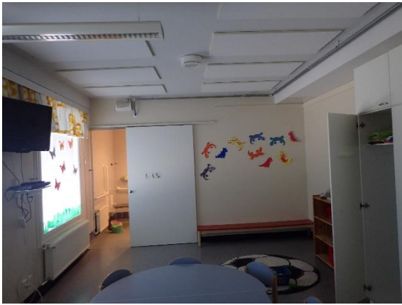
Kuva 213 2002 rakennuksen tyypillistä kipsilevykattoa. Akustiikkaelementit olivat akustovillalevyjä.
