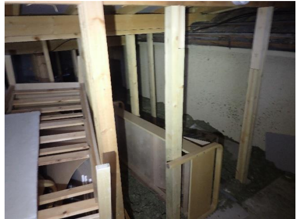
Kuva 200 Luukusta oli näkymä yläpohjatilaan, ilmanvaihtokonehuoneiden edustalle 2. kerroksen tasolla.
