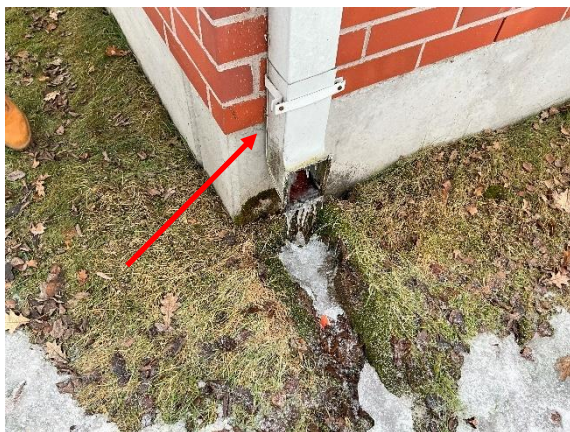
Kuva 38 Rakenneavaus US1 sijaitsee kuvassa olevan sadevesikaivon taustalla ulkonurkkauksessa.
