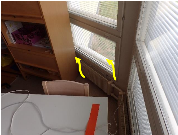
Kuva 100 MA 12 US. Merkkiaineen vuotoa ikkunaliittymistä, Kalusteasennuksen taustasta ja sähköasennusten kautta.
