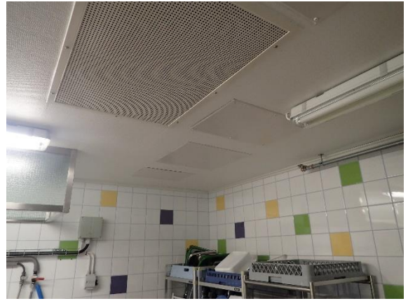
Kuva 212 Keittiötiloissa oli alaslaskut kipsilevyä. Asennuksia ja luokkuja oli runsaasti.
