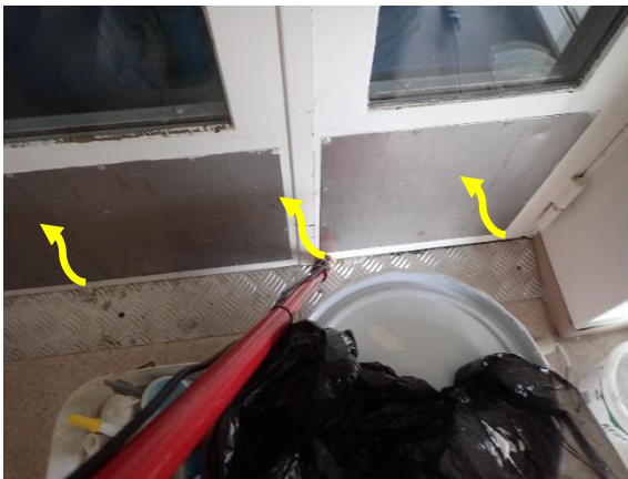
Kuva 232 Alipaineistusjärjestely. Keittiön ovet kii- lattiin auki tutkimuksen ajaksi.
