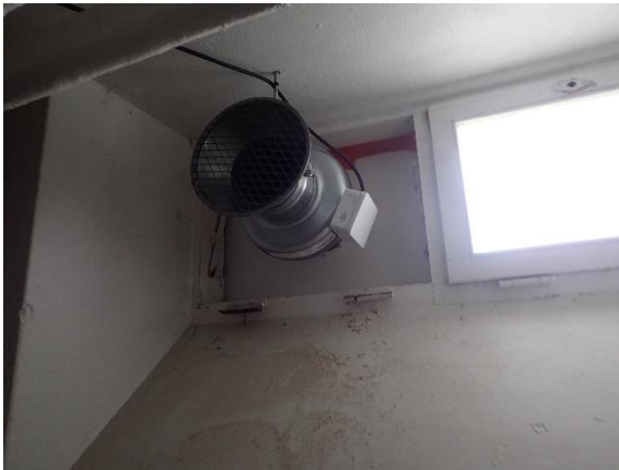
Kuva 226 Kanavapuhaltimet olivat pienikokoisia ja imivät suoraan huonetilasta ilman imu-kanavistoa.
