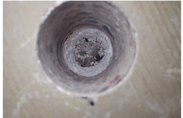
Kuva 41 Rakenneavaus AP10. Rakenneavauksen kohdalla todettiin teräsbetonilaatan paksuudeksi 90 mm. EPS-eristeen päällä oli rakennusmuovi.
