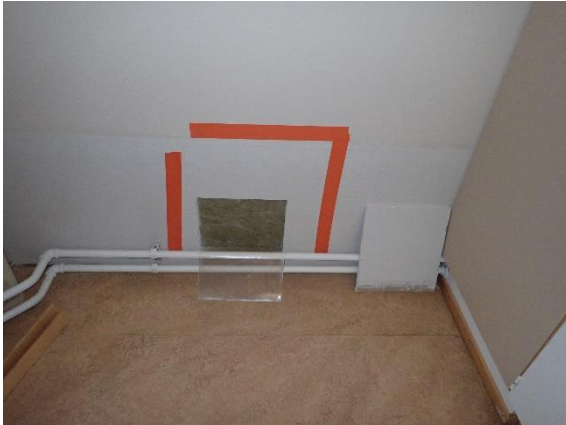
Kuva 24 Ulkoseinän rakenneavaus US4.
