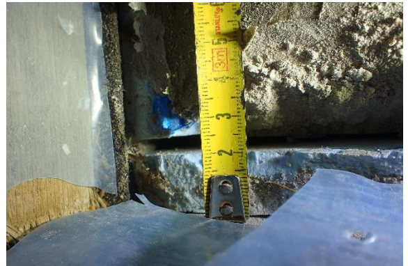
Kuva 49 Kosteiden tilojen lattiapinnat olivat samassa tasossa muiden tilojen kanssa. Pinnoitteena oli muovimatto. Kosteuspikkeamia ei havaittu. Kosteissa tiloissa todettiin olevan lattialämmitys.
