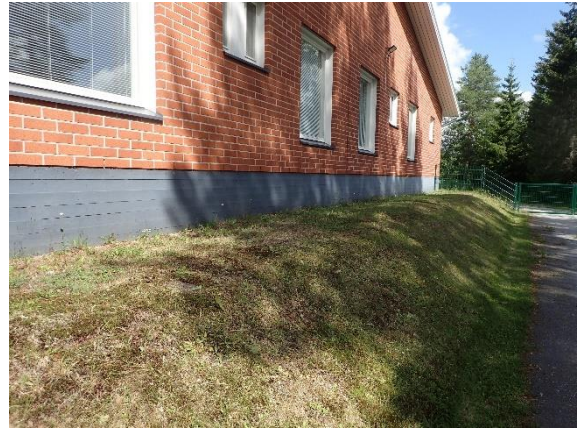
Kuva 75 Muurattua julkisivua. Muurauksen alimassa tiilikerroksessa oli asianmukaiset tuuletusjärjestelyt.
