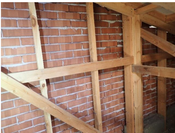
Kuva 193 Päätyseinän tiilimuurausta.
