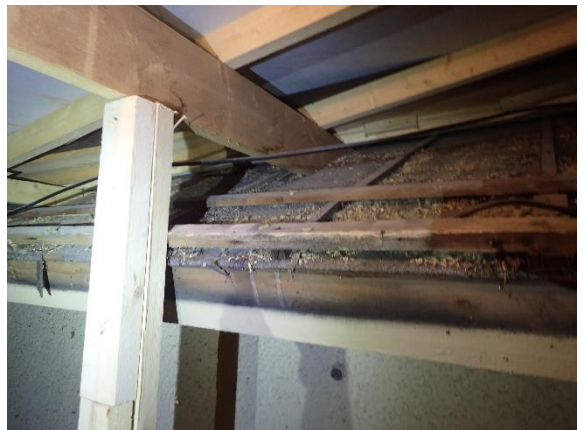
Kuva 174 YP7. Esimerkkikuva uuden ja vanhan kattorakenteen liittymisestä toisiinsa rakennearauksen alueella.
