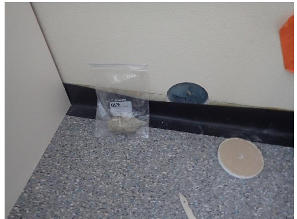
Kuva 89 US7. Rakenne tarkastettiin alajuoksun päältä ja otettiin materiaalinäyte.
