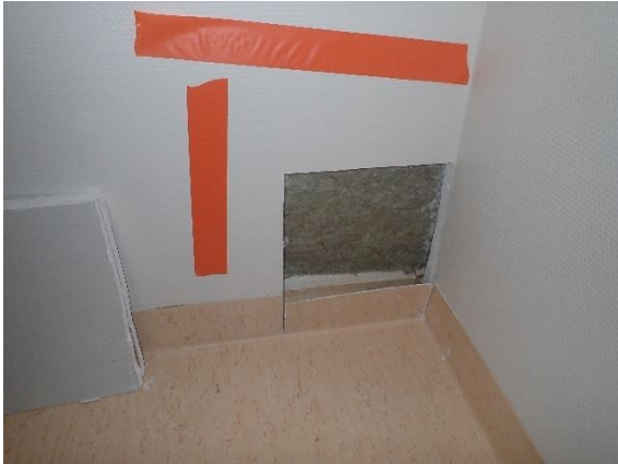
Kuva 65 Siivouskeskus-tilan ja asunnon väliseen väliseinärakenteeseen tehty rakenneavaus (VS1).
