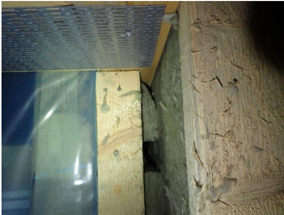
Kuva 149 YP2. Kattoristikko ja pystyseinä korkeuseron kohdalla.
