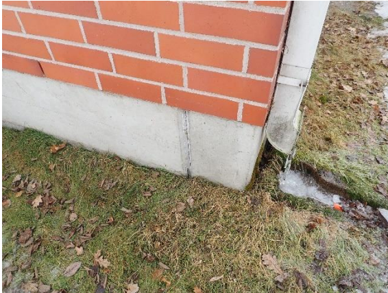
Kuva 30 Sokkelielementtien elementtisaumaukset olivat ikäänntyneitä ja niissä esiintyi epätiiveysohkoita.
