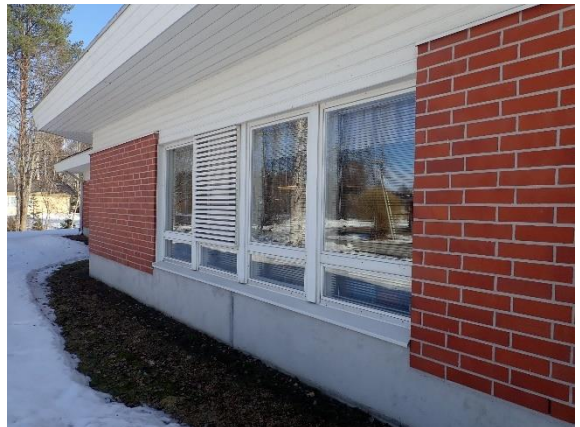
Kuva 27 Tiilijulkisivut olivat hyväkuntoisia.
