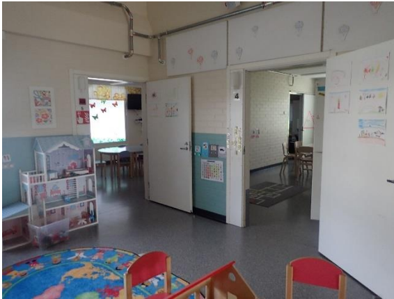
Kuva 48 2002 rakennuksen tilojen pinnoitteena oli muovimatto. Muovimattojen kunto oli hyvä.
