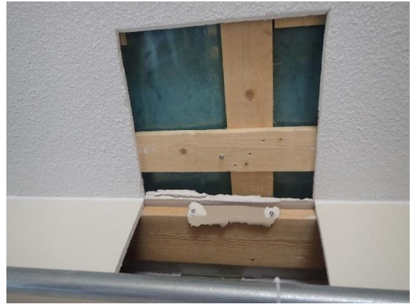
Kuva 180 YP8. Rakenneavausta tehtiin ulkoseinä- liittymään, katon ja seinän suuntaan.
