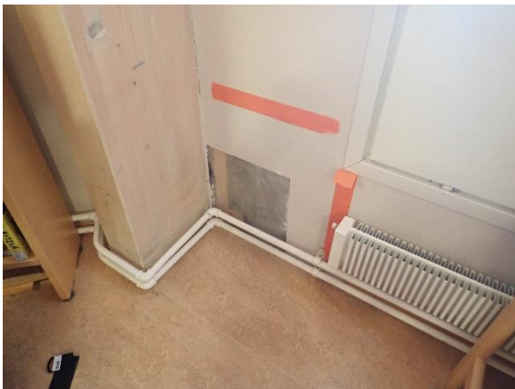
Kuva 18 Ulkoseinän rakenneavaus US2.
