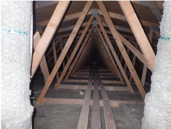
Kuva 145 1992 rakennuksen ullakkotilaa, jossa oli asianmukainen kulkusilta.
