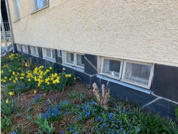
Kellarikerros sijaitsee osittain maanpinnan alapuolella.
