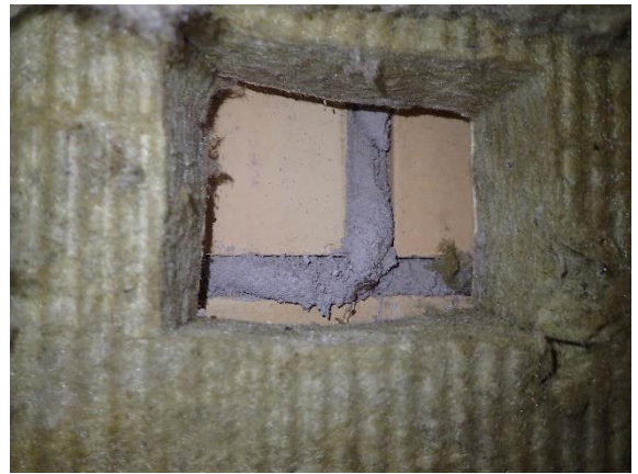
Kuva 81 US3. Tuulensuojavillan takana oli moduliitti. Tuuletustila oli noin 20 mm.
