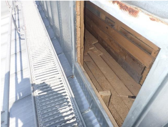
Kuva 199 Luukku pystyseinässä 2002 rakennusosalla.
