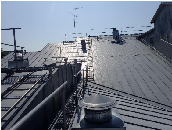
Kuva 189 Vesikatteiden, läpivientien ja kattovarusteiden kunto oli hyvä.
