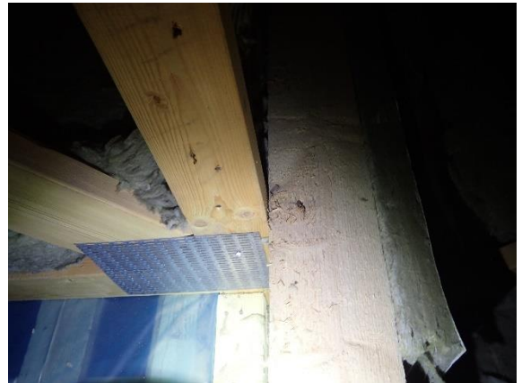
Kuva 148 YP2. Kattoristikko ja pystyseinä korkeuseron kohdalla.
