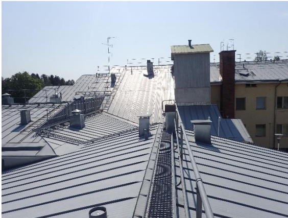
Kuva 191 Vesikatteiden kunto oli erittäin hyvä.
