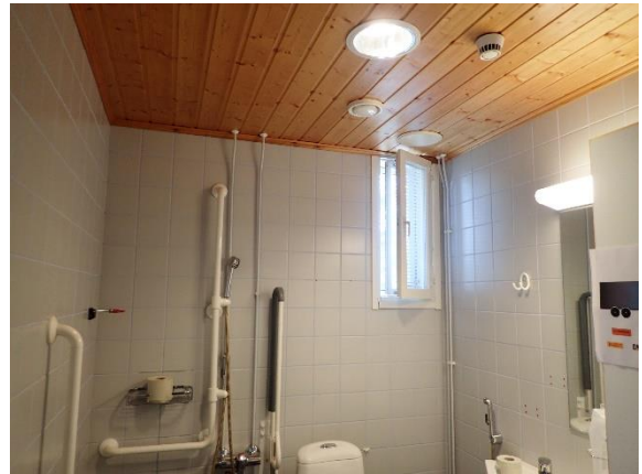
Kuva 214 2002 rakennuksen WC-tiloissa oli paneloidut alaslaskut.
