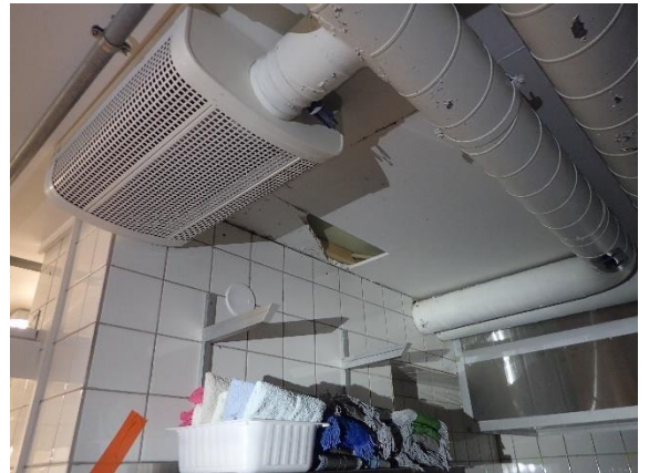
Kuva 160 YP4. 1950 yläpohjaa ennen keittiön ja 2. kerroksen laajennusta. Liittymä ja rakenne oli alaspäin keittiötiloihin tiivis betonivalu.
