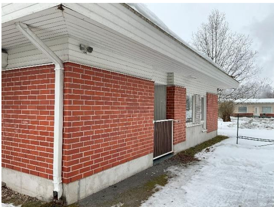
Kuva 28 Tiilijulkisivut olivat hyväkuntoisia. Julkisivujen yläosien laudoitettujen osien maalipinta oli paikoin kulunut.
