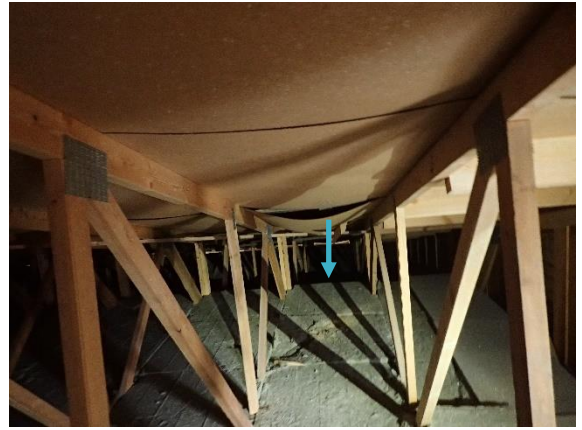
Kuva 146 1992 rakennuksen ullakkotilaa. Aluskatteena oli kovalevy. Sinisen nuolen kohdalla on keski- ja reuna-alueen raja.
