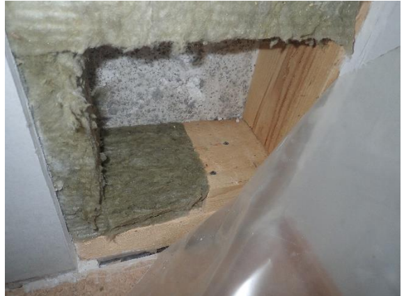
Kuva 17 Rakenneavauksessa ei silmämääräisesti havaittavissa viitteitä vaurioista (US1).
