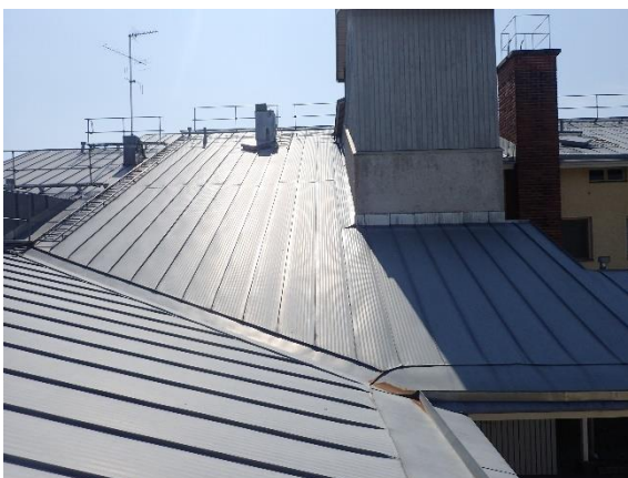
Kuva 187 Yleiskuvaa vesikatosta. Vesikatto oli varustettu jalkarännein.
