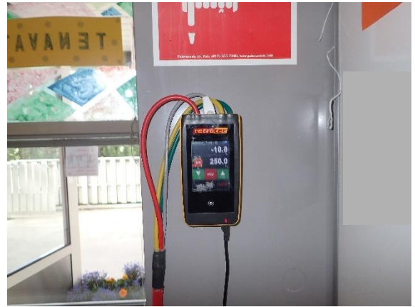
Kuva 57 Alipaineistuslaitteistolla saavutettiin vähintään -10 Pa alipaine ulkoilmaan verraten.
