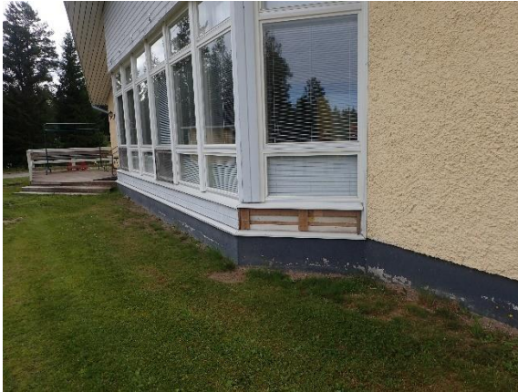
Kuva 76 US1. Erkkerin puuverhoilu oli sään kulluttamaa.
