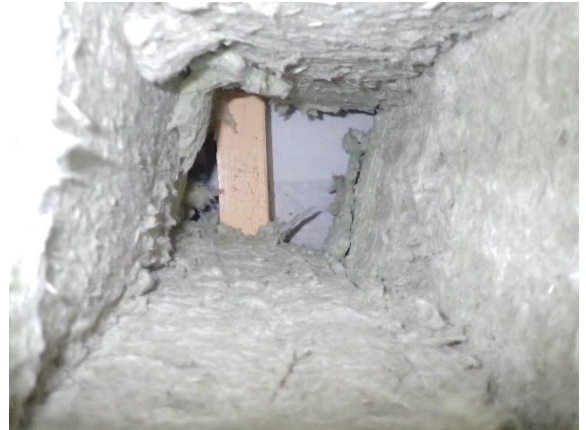
Kuva 184 YP8. Yläpohjarakenteessa oli mineraalivilla 420 mm.
