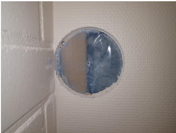
Kuva 123 VS6. Havaintojen perusteella puurunko- rakenne päättyi toimistohuoneen ja WC- tilan rajalla olevan kantavan väliseinän kohdalla. Seinärakenne WC:n, ja kodin- hoitohuoneen kohdalla oli kahitiilimuu- rattua rakennetta (varmistettu porauk- sella kodinhoitohuoneesta).
