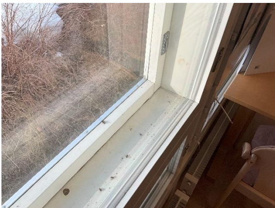
Kuva 34 Rakennuksen ikkunat MSE-ikkunoita. Ikkunat olivat hyväkuntoisia.
