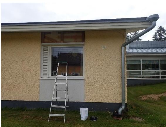
Kuva 82 US8. Ikkunan yläpuolinen panelointi puurettiin.
