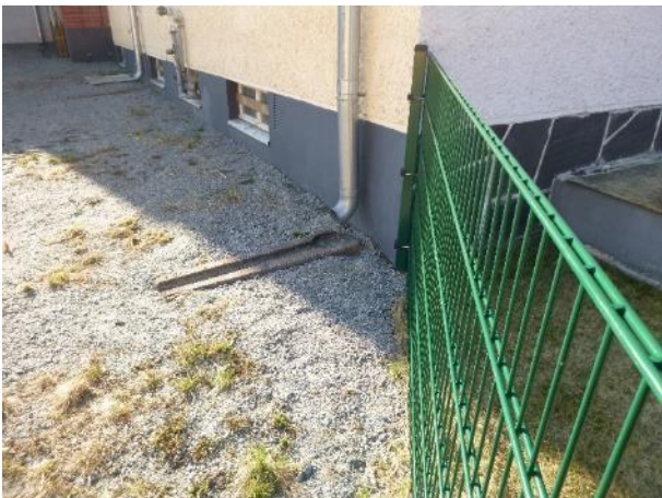
Seinustalle ulottuva kasvillisuus lisää lattia ja seinärakenteelle aiheutuvaa kosteusrasitusta.
