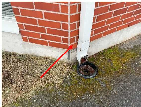
Kuva 39 Rakenneavaus US3 sijaitsee kuvassa olevan sadevesikaivon taustalla ulkonurkkauksessa.
