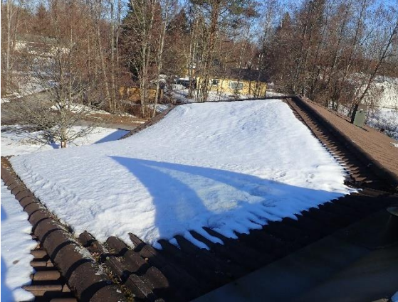
Kuva 55 Vesikate oli tarkastushetkellä osittain lumipeite.
