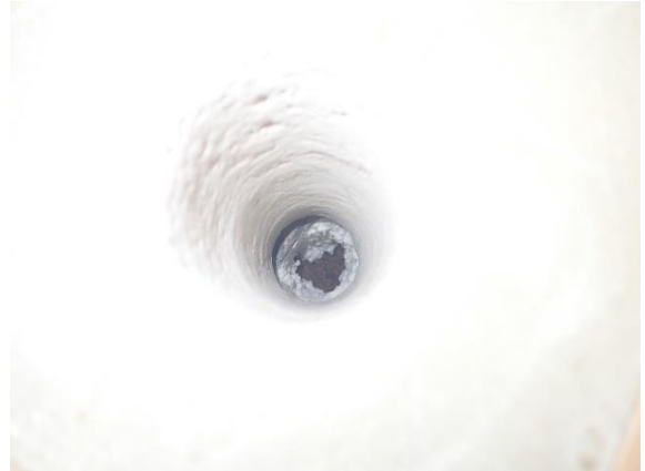
Kuva 47 Alapohjarakenne on toteutettu pääosin rakennesuunnitelmien mukaisesti.
