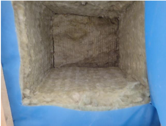
Kuva 157 YP3. Levyyvillaa oli 200 mm.
