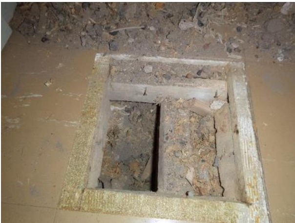
Rakenneavaus välipohjaan.
