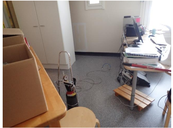
Kuva 61 MA 8 AP. Kaasunlaskupiste alapohjaan 2002 rakennuksen toimistossa.
