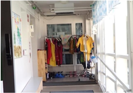
Kuva 216 Yhdyskäytävältä 1950-luvun rakennukseen johtava suljettu ovi.
