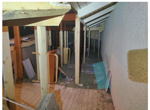
Kuva 162 YP6. Rakenneavauksen sijainti 1950-luvun rakennuksen liittymän alueella on korostettu sinisellä.
