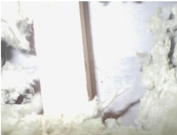
Kuva 185 YP8. Mineraalivillojen päällä näkyy lappeen suuntaiset juoksut 50 x 100 mm ja aluskate.
