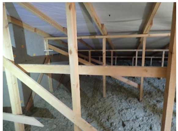
Kuva 194 Palkkistoon tukeutuvaa puupukkirakennetta. Aluskate oli siisti, eikä viitteitä vesivuodoista havaittu.
