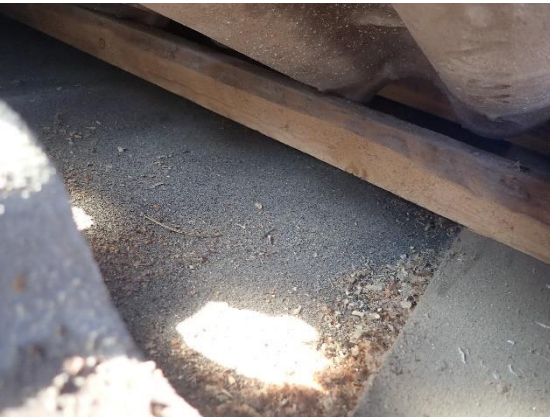
Kuva 57 Betoniitilikatteen alla aluskatteena bitumikermikate.
