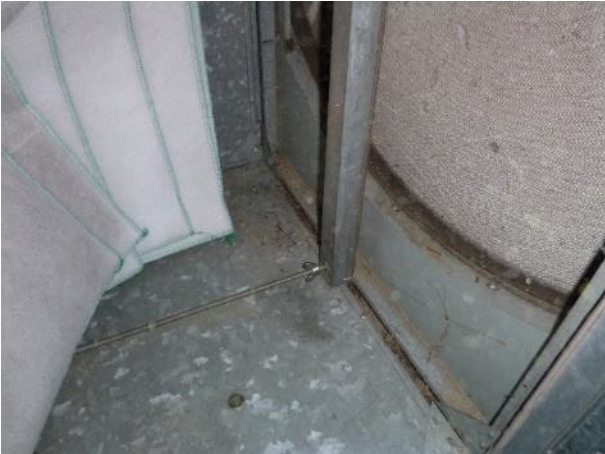
Raitisilmakammion pohjalla epäpuhtauksia ja veden kuivumisjälkiä.
