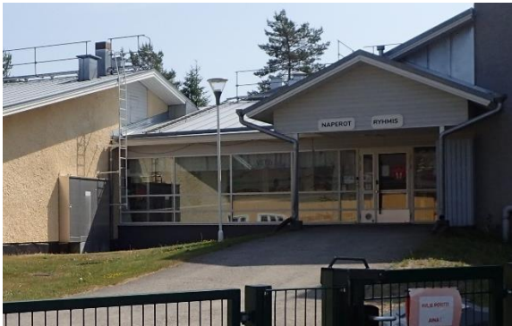
Kuva 159 Yhdyskäytävän vesikaton ylärakenteet on purettu ja vesikatto on yhdistetty muihin kattoihin, 2002 rakennusvaiheen yhteydessä.
