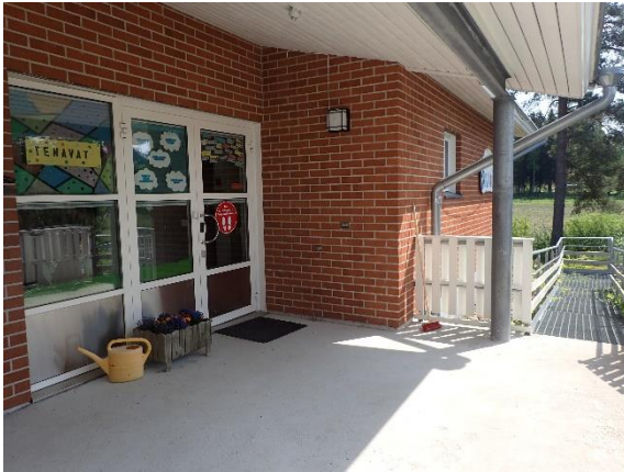
Kuva 74 2002 rakennus. Puhtaaksimuuratut julkisivupinnat, ulko-ovet ja ikkunat olivat hyväkuntoisia.
