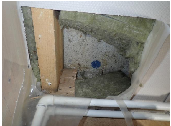
Kuva 19 Rakenneavauksessa ei silmämääräisesti havaittavissa viitteitä vaurioista (US2).
