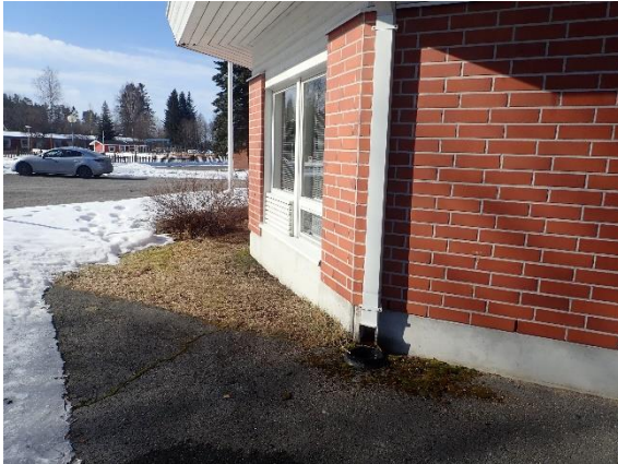
Kuva 8 Kattovedet on johdettu syöksytorvien kautta sadevesikaivoihin.
