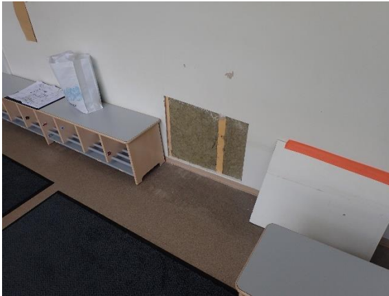
Kuva 125 VS2. Yhdyskäytävän luiskan kohdalla 2002 vuoden rakenteita vasten.
