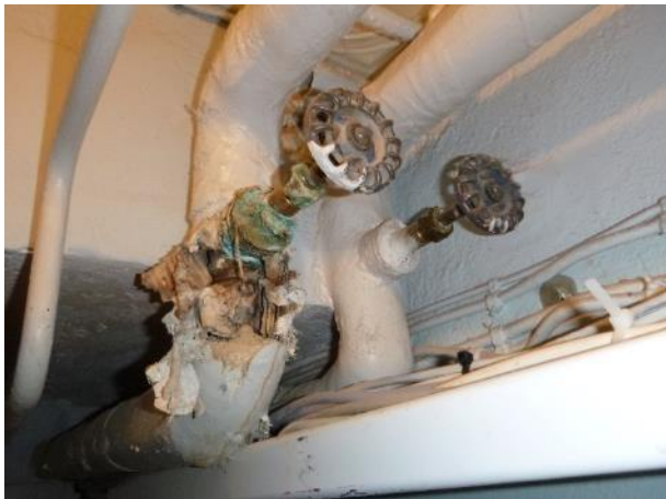
Tasopinnoilla esiintyvää pölyä.
