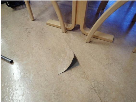
Kuva 44 Kirjastosalin muovimaton alustaan tehtyyn tarkastus AP1 rakennetarkastuspisteen kohdalle.
