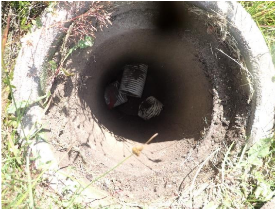
Kuva 10 1992 rakennetulla osalla salaojakaivot olivat betonikaivoja. Havaintojen perusteella kaivot olivat toimintakuntoisia.
