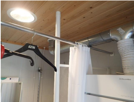
Kuva 211 Yhdyskäytävän luiskan alapäässä, wc-tilan paneloitua alaslaskua.
