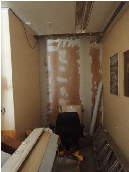
Kuva 218 Kuvan 217 suljettu ovi takapuolelta. Kulkuaukko oli umpeen levytetty ja tiivistysteipattu.
