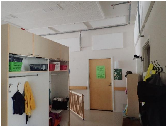
Kuva 205 1992 rakennuksen ryhmätiloja. Akustiikkaelementteinä oli perforoitua kipsilevyä ja akustovillalevyjä.
