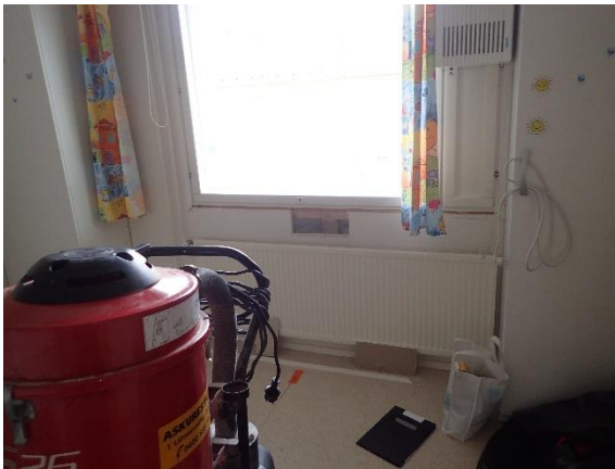
Kuva 80 US3. Rakenneavauksen sijainti ikkunan alla.
