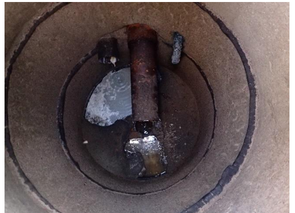
Kuva 19 Näkymä avattuun kaivoon. Kaivo oli havaintojen perusteella ehjä ja toimintakuntoinen.
