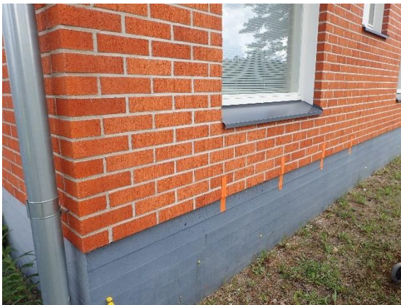
Kuva 92 Merkitäinekaasua laskettiin ulkoseinän tuuletustilaan 2002 rakennuksessa tiimurauksen tuuletus saumaväleistä. Lähistön muut tuuletusvälit teipattiin umpeen.
