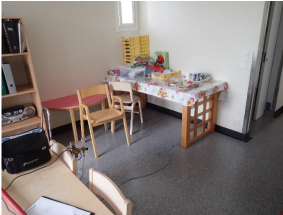
Kuva 60 MA 2 AP. Kaasunlaskupiste alapohjaan 2002 rakennuksessa, huoneessa 1. Ennen kaasun laskemista, todettiin kaasun levinneen poraukseen pisteestä MA 1 AP.
