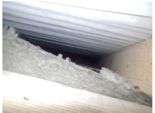
Kuva 186 YP8. Kuvassa edessä harjansuuntaisen palkin yläpintaa etualalla. Lappeen-suuntaisten juoksujen välissä oli riittävä tuuletustila 80...100 mm.
