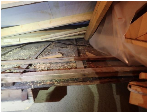
Kuva 173 YP7. Esimerkkikuva uuden ja vanhan kattorakenteen liittymisestä toisiinsa rakennearauksen alueella.
