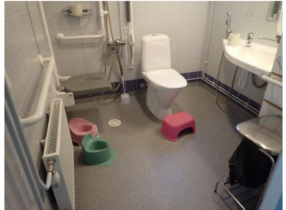
Kuva 49 Kosteiden tilojen lattiapinnat olivat samassa tasossa muiden tilojen kanssa. Pinnoitteena oli muovimatto. Kosteuspikkeamia ei havaittu. Kosteissa tiloissa todettiin olevan lattialämmitys.
