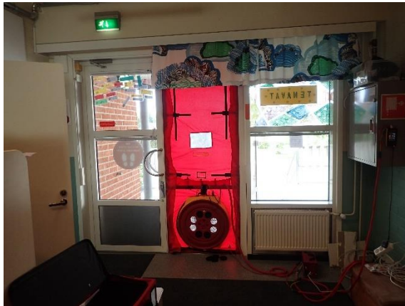
Kuva 56 Esimerkkikuva alipaineistusjärjestelystä Retrotec -ovipuhallinlaitteistolla.
