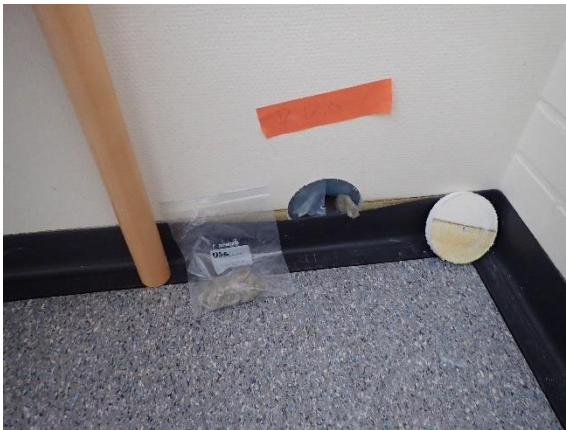
Kuva 88 US6. Rakenne tarkastettiin alajuoksun päältä ja otettiin materiaalinäyte.
