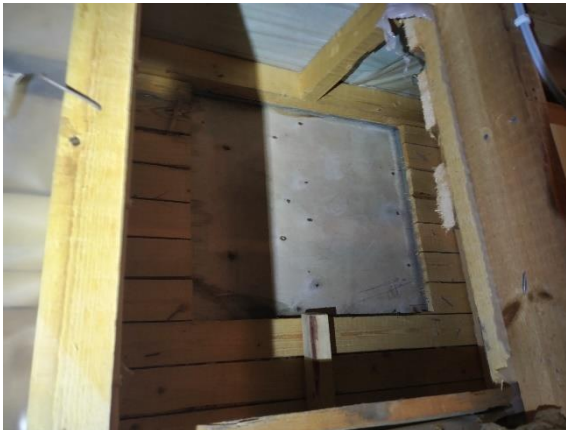
Kuva 201 Kuvan 199 luukku sisältäpäin kuvattuna.
