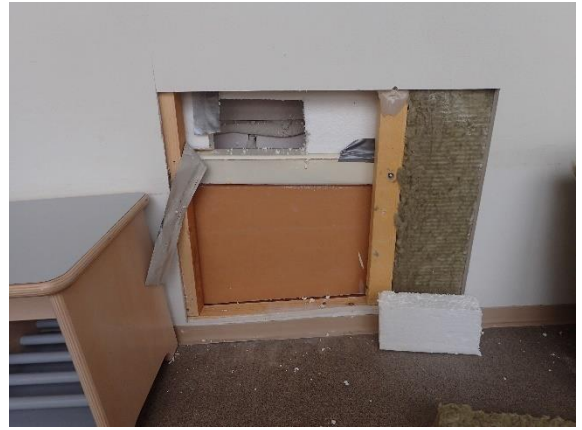
Kuva 126 VS2. Kuvassa näkyvissä alkuperäistä kantavaa teräsrakennetta ja alaosan sokkeliä vasten olevaa uretaanieristelevyä. Sokkelin päältä rakennetta on nostettu 2002 rakennusvaiheessa kahitiili-muurauksella. Eristelevynä uudessa rakenteessa oli käytetty EPS-levyjä ja mineraalivillaa. Rakenteessa ei ollut höyrynsulkumuovia.
