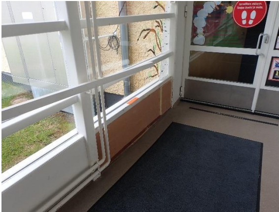
Kuva 84 US4. Yhdyskäytävän sisäpinnalla ikkunoiden alla oli verhousmateriaalina peltilevyt 100x100 putkitolppien välillä.
