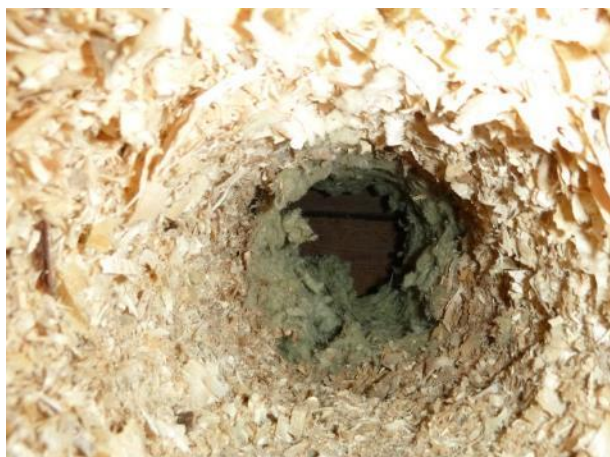
Rakennearaus yläpohjaan.
