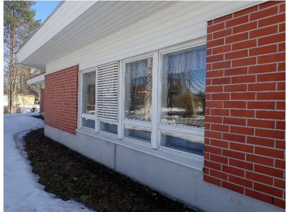
Kuva 33 Rakennuksen ikkunat MSE-ikkunoita. Ikkunat olivat hyväkuntoisia.
