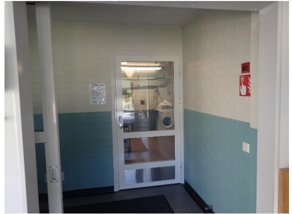
Kuva 217 2002 rakennuksen käytävältä keittiötiloihin johtava ovi. Ovenssa ei ole kynnystä.
