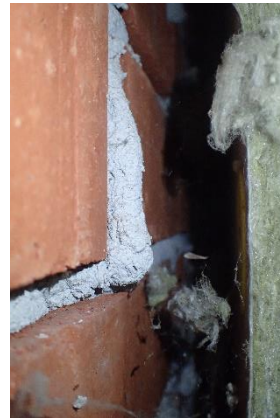
Kuva 87 US5. Tuulensuojavillan takana oli tuuletusväli noin 35 mm.
