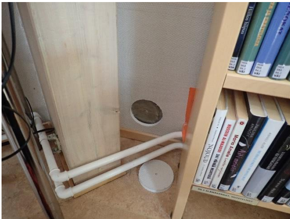
Kuva 26 Ulkoseinän rakenneavaus US5.
