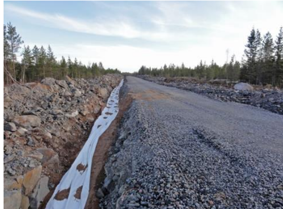
Kuva 20. Maakaapelit upotetaan huoltoteiden yhteyteen (Kuvat: FCG).
