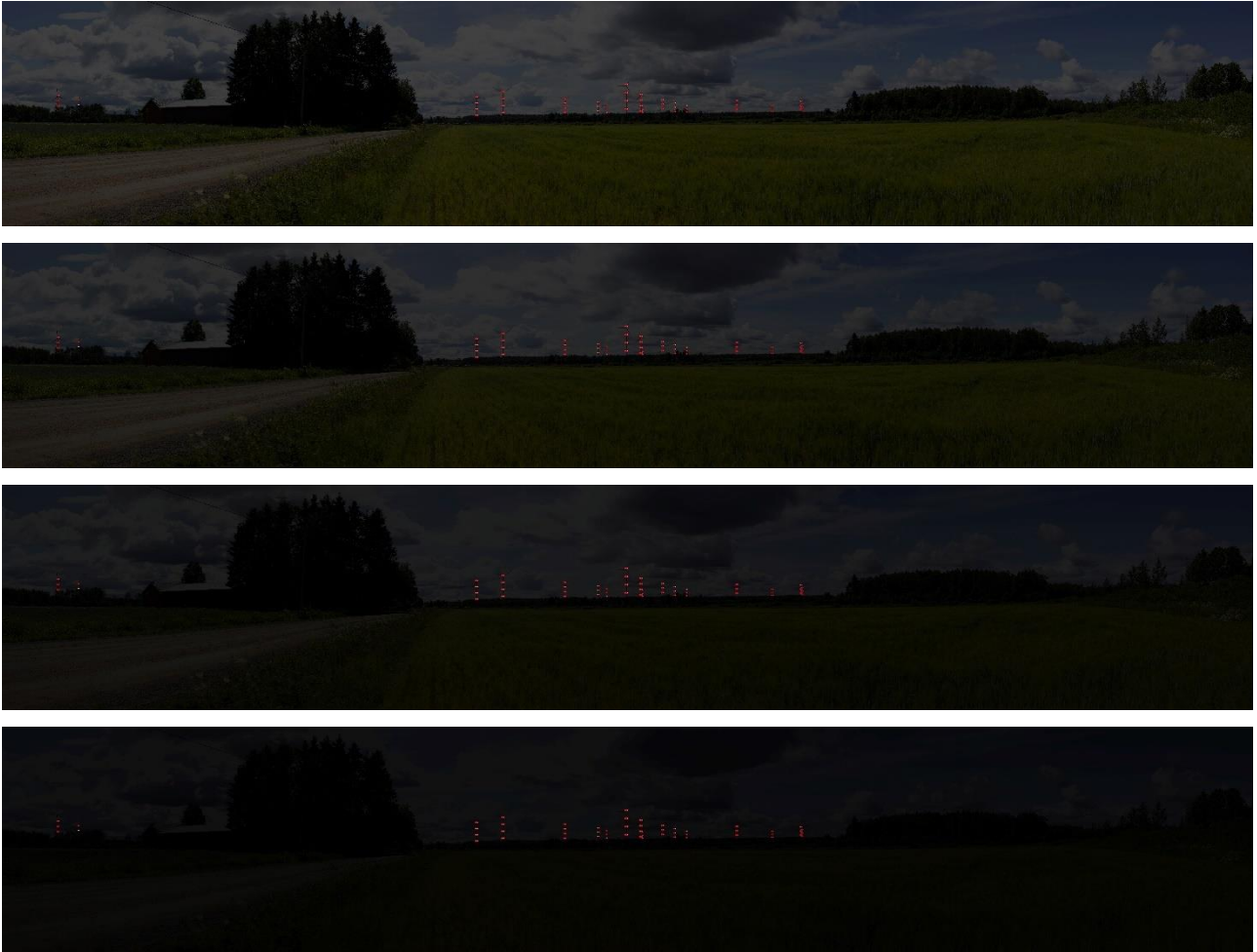
Kuva 123. Yöhavainnekuva kuvauspisteestä 2 Paasto, yhteisvaikutukset. Ylimmässä kuvassa itähämärä, toisessa kuvassa hämärä, kolmannessa hämärämpi ja neljännessä kuvassa pimeä. Kuvassa näkyvän rakennuksen vasemmalla puolella on esitetty alueelle suunnitellun Paholammin tuulivoima-alueen tuulivoimalat. Tien oikealla puolella ovat Haukkasalon suunnitellut voimalat. Kuvauksessa on käytetty digikameraa, joka asetuksiltaan säädetty mahdollisimman lähelle ihmissilmällä havaittavaa kuvaa, eli kinofilmikameran 50 mm objektiivia. Kuvat on yhdistetty panoraamakuviksi kuvankäsittelyohjelmalla havainnekuvia laadittaessa.
