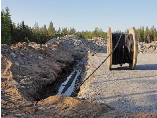
Kuva 20. Maakaapelit upotetaan huoltoteiden yhteyteen (Kuvat: FCG).
