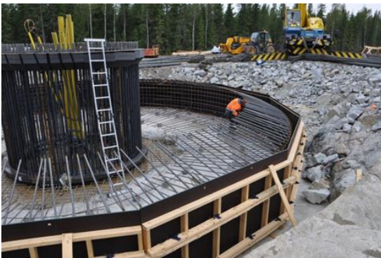
Kuva 21. Tuulivoimalan perustusten rakentamista (Kuvat: FCG).
