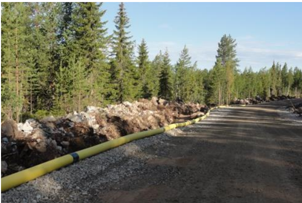
Kuva 16. Vasemmalla: Esimerkki tuulivoima-alueen rakennus- ja huoltotiestä. Maakaapeli sijoitetaan ojakaivantoon tien reuna-alueelle. Oikealla: Tuulivoimalan osia kuljetetaan erikoiskuljetuksina. (Kuvat: FCG).
