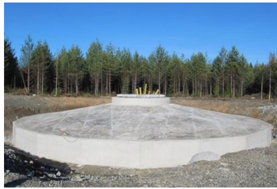
Kuva 21. Tuulivoimalan perustusten rakentamista (Kuvat: FCG).
