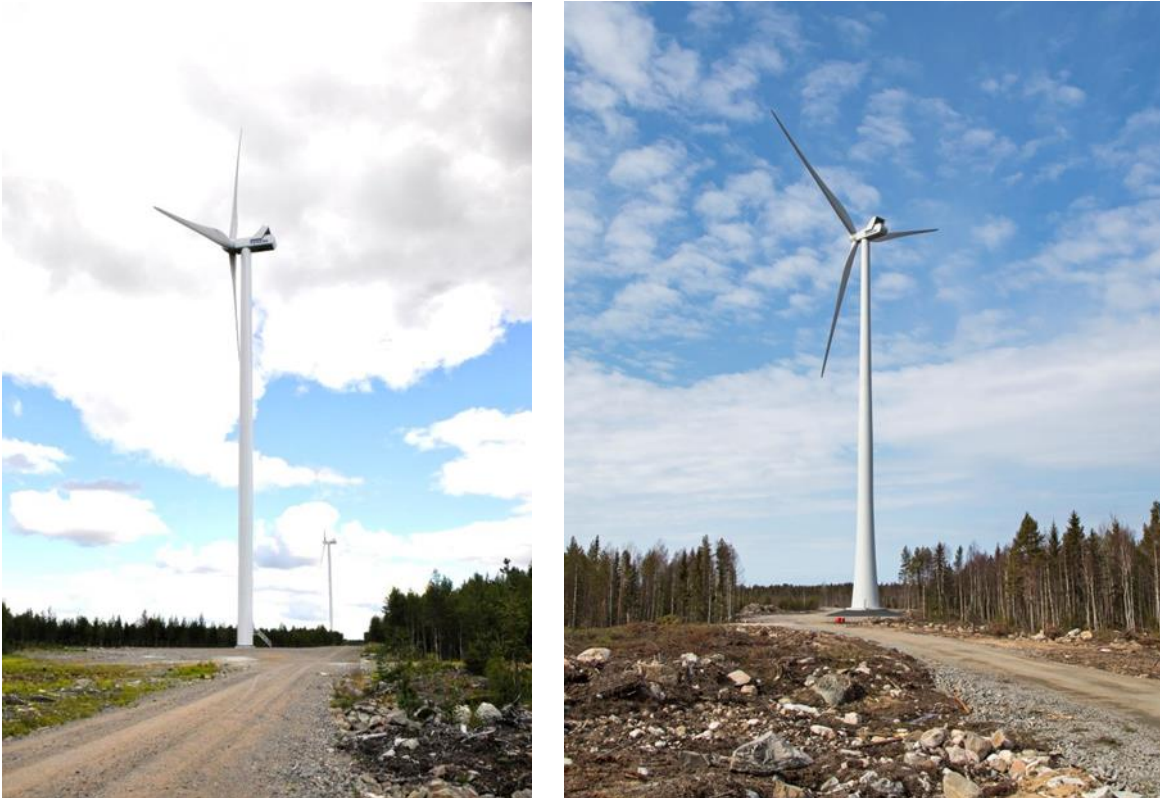
Kuva 10. Vasemmalla on esimerkki teräslieriötornista ja oikealla hybriditornista. (Kuvat: Leila Väyrynen ja Ville Suorsa, FCG)
