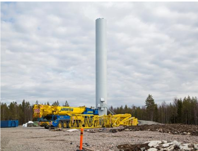
Kuva 22. Tuulivoimalan kokoamista (Kuvat: FCG).
