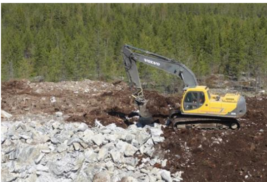
Kuva 19. Tuulivoima-alueen rakentaminen alkaa huoltoteiden ja pystytysalueiden rakentamisella (Kuvat: FCG).
