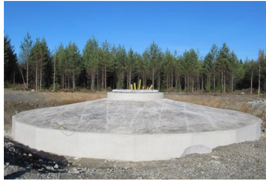
Kuva 21. Tuulivoimalan perustusten rakentamista (Kuvat: FCG).
