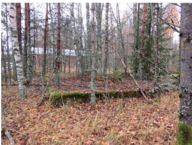
23. Luukkilan talon perustus etelään.
