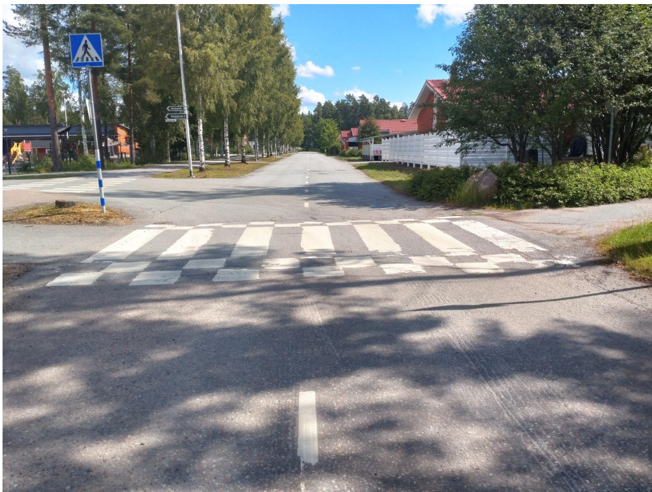
Kuva 7. Asfaltilla toteutettu korotettu suojatie.
