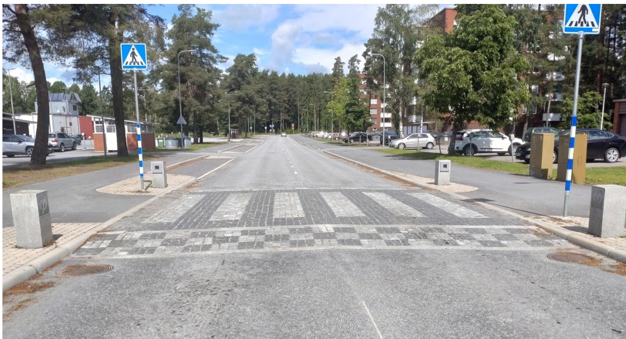
Kuva 6. Luonnonkivellä toteutettu korotettu suojatie.
